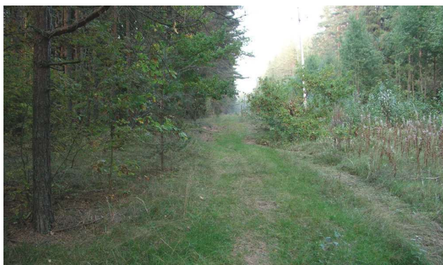
3. Elektriliini all on võsatõrje tõttu alati rohumaa
